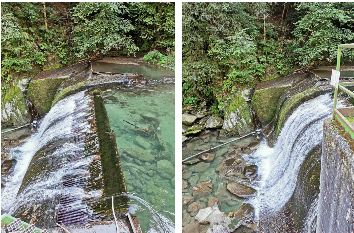
Figura 12: vista della griglia di presa
